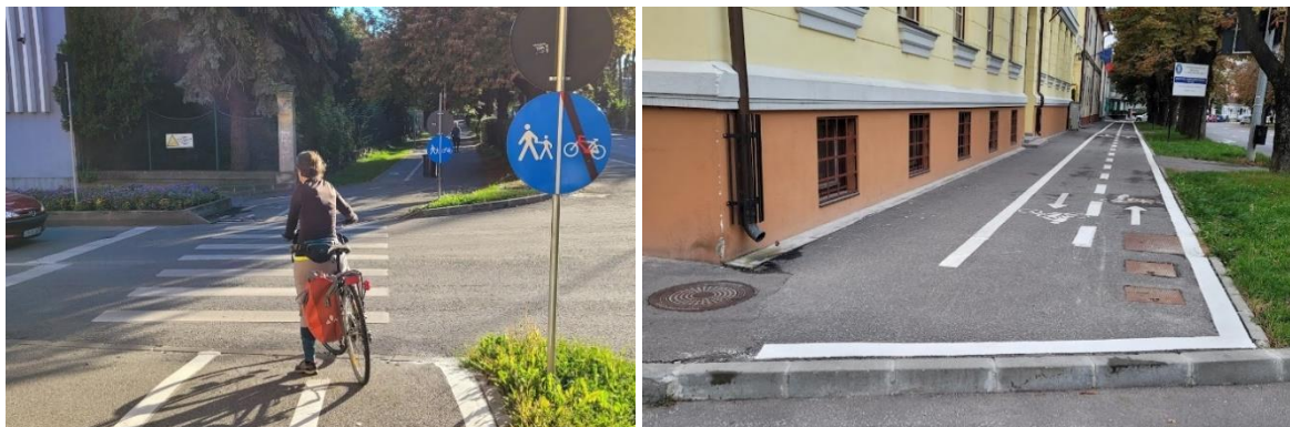
Intersecții nerezolvate pe pista pentru biciclete de pe strada Kós Károly
