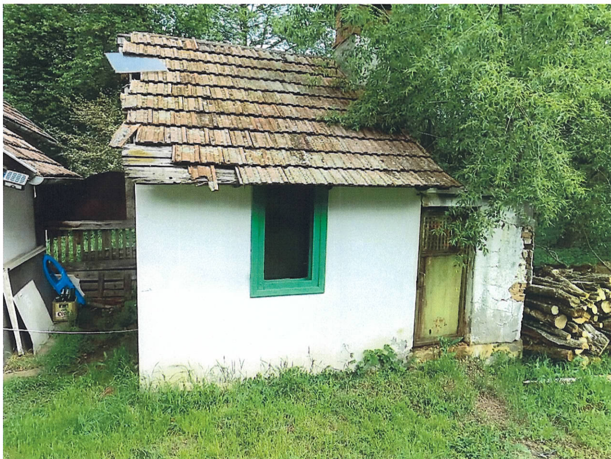
C6 - clădire WC (actual magazie)
