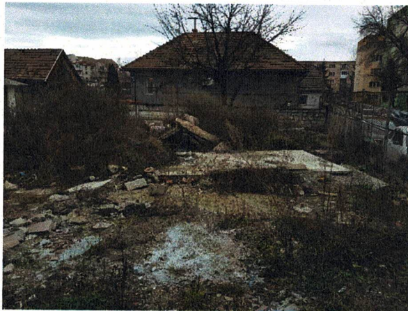
27292-C8 – Clădire autoprăbușită – Garaj – în prezent pe teren se regăsește fundația clădirii, respectiv elementele prefabricate din beton relocate lângă fundația clădirii
