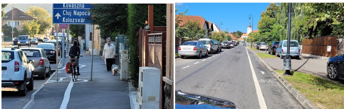
Lățimea insuficientă a pistelor pentru biciclete
