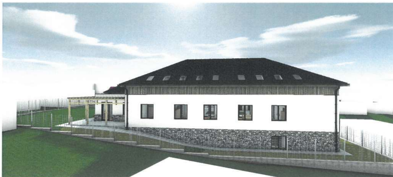
VEDERE – FATADA EST
