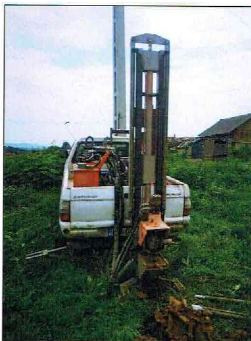
Foto 1. Aspectul terenului investigat și instalația de foraj geotehnic Pride Mount 20 utilizat.
