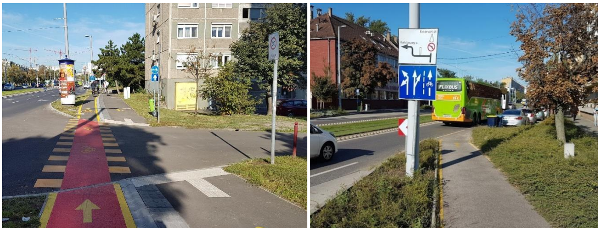
Transfer de pistă de biciclete la limita unei zone cu trafic redus, reconectarea unei piste de biciclete la o bandă pentru biciclete pe șosea
