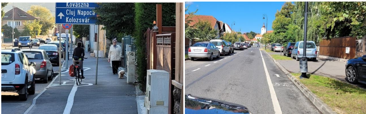
Lățimea insuficientă a pistelor pentru biciclete
