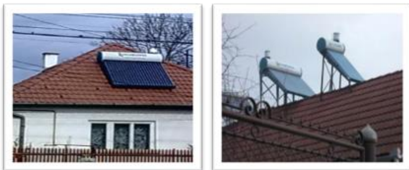
PANOURI SOLARE PENTRU PRODUCEREA APEI CALDE MENAJERE
