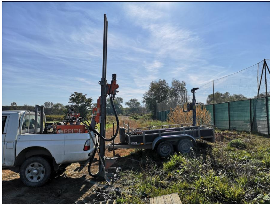
Foto 1.: Aspectul terenului investigat cu instalația de foraj geotehnic Pride Mount 20 și cu instalația de sondă de penetrare utilizată.
