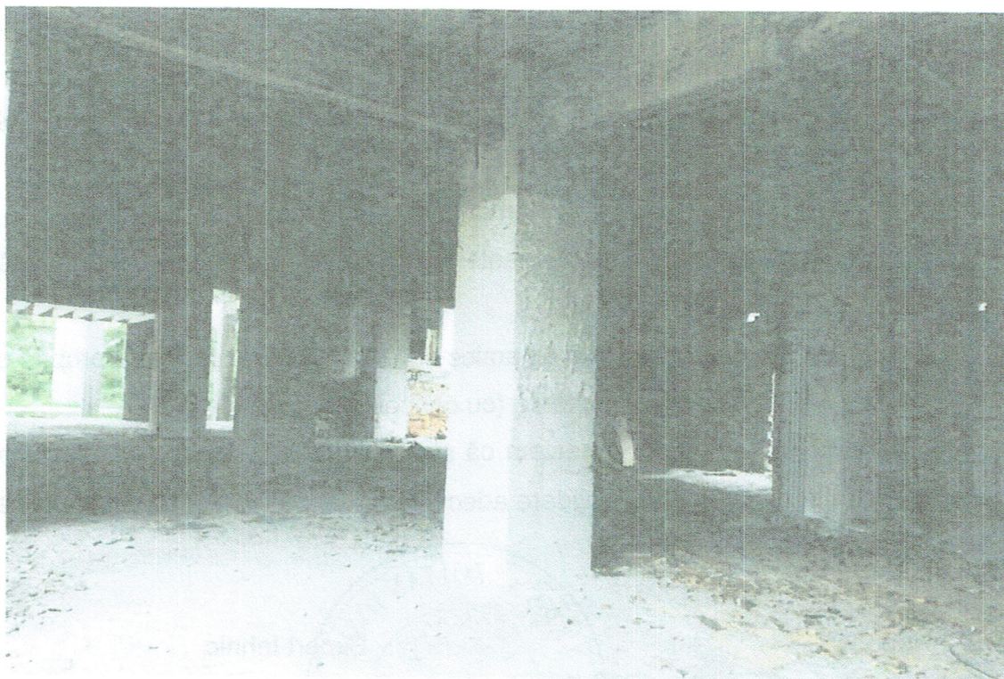
Foto 2. Stâlpii existenți consolidați.
