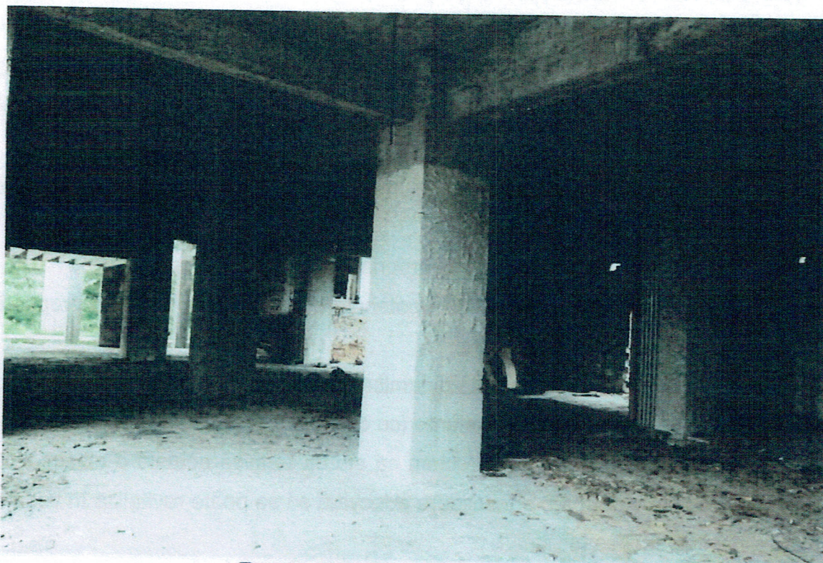
Foto 2. Stâlpii existenți consolidați.
