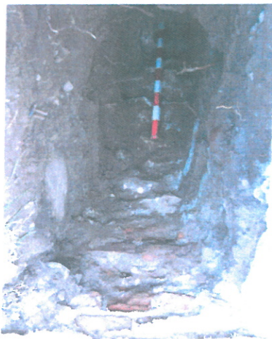
Fundația dezvelită (adâncimea de fundare: 1,80 m)
