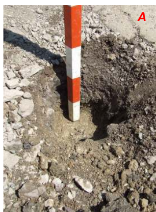
Sondaje de verificare a continuității stratului de beton din zona sondajului S 2
