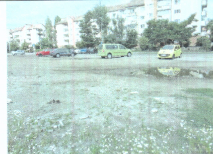
Vedere spre N-V
