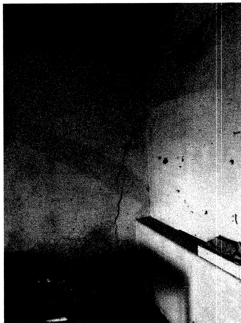
Crapatura pe aripa veche (din interiorul aripii noi)
