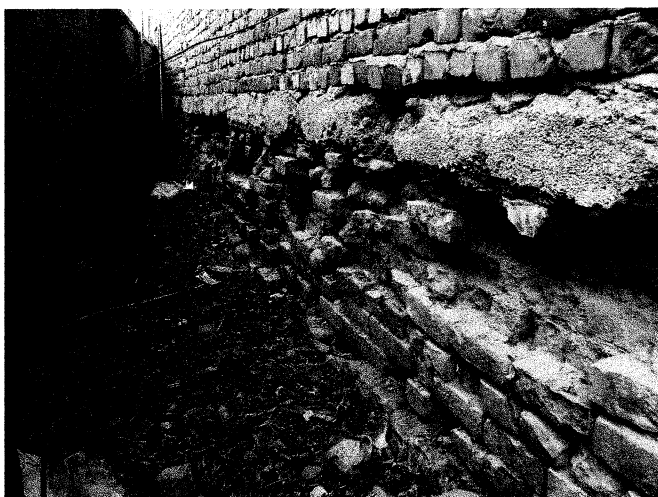
Elevatia degradata sub centura de beton armat pe latura estica
